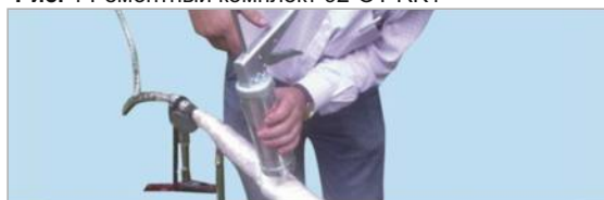
Рис. 2 Применение ремонтного комплекта 92-OT Rk1 для ремонта текущей оболочки кабеля или текущего кожуха соединительной муфты типа СЭФ, СС либо термоусаживаемой муфты.
