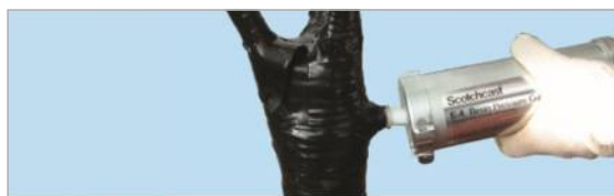
Рис. 3 Применение ремонтного комплекта 92-OT RK 1 для ремонта текущей концевой заделки
